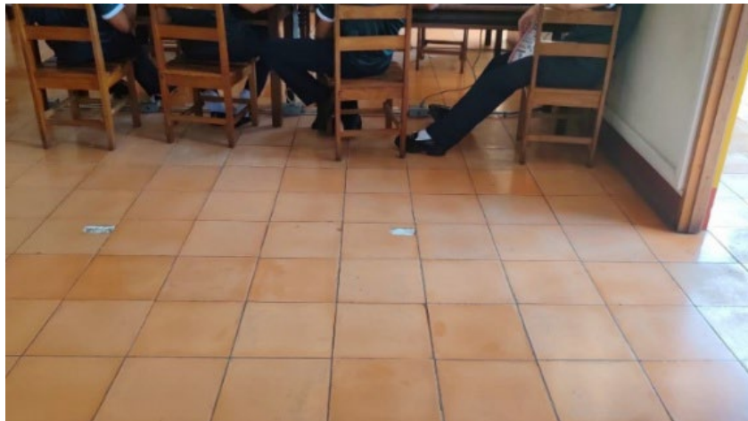
Anexo 5 – Foto. Tomas Eléctricas de Piso
